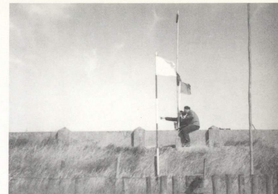
Heel lang zijn walploegen nodig geweest tijdens het uitvoeren van metingen. Aan de wal werden met behulp van vlaggen zogenaamde 'zichtraaien' uitgezet. Het meetschip voer dan al metend naar de wal, terwijl de schipper trachtte de vlaggen in één lijn te houden. De afstand in de raai was bepalend voor de plaats van het schip (foto: privé-archief J. van Eijk)
